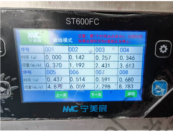
图 33 水泵调节流量界面
